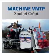
MACHINE VNTP Spot et Crépi Linéaires VNTP Routes, autoroutes
