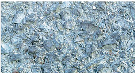
Enduit 10/14 + 4/6 - Double gravillonnage - PMT : 1,4 mm
